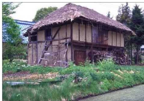
屋根材がワラの例
